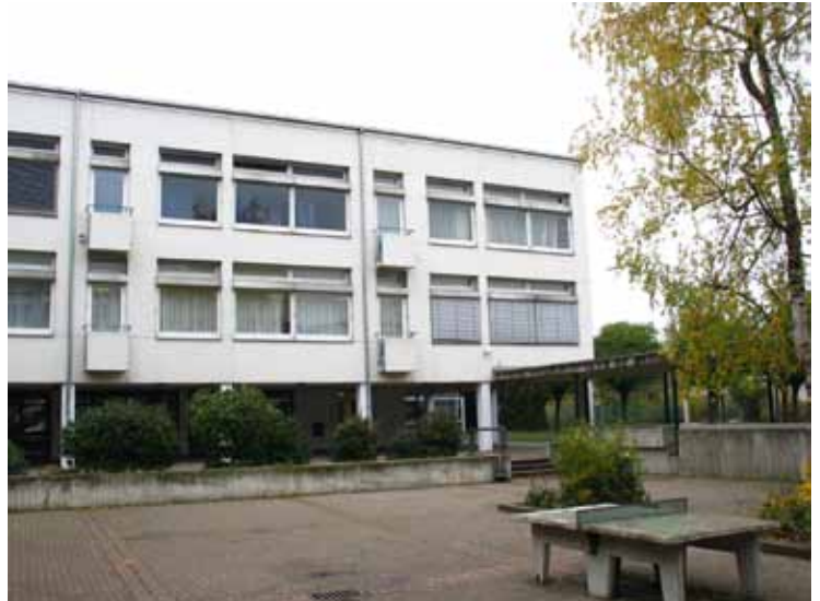
Abb 1: Gymnasium Baesweiler, Trakt 1 vor der Sanierung
