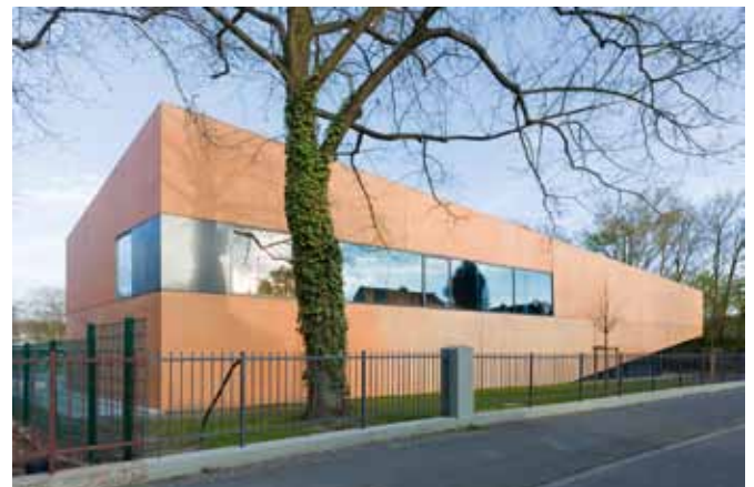
Erweiterung Grundschule Buschfeldstraße Köln zur Ganztagschule
