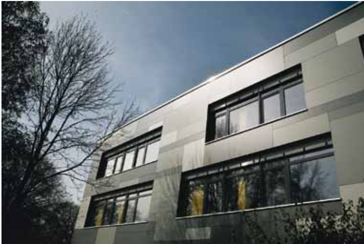
Abb 2: Gymnasium Baesweiler, Trakt 1 nach der Sanierung, Südseite
