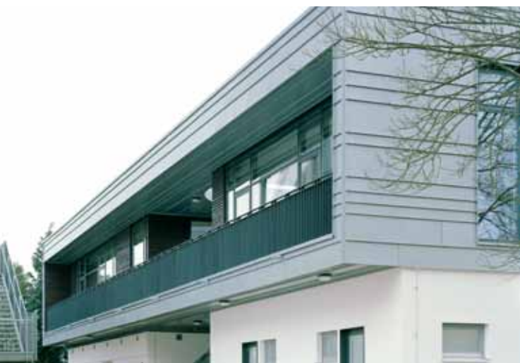
OGS-Erweiterungsbau Grundschule Herringhausen, Herford Architekt(inn)en: fun Architekten, Herford
